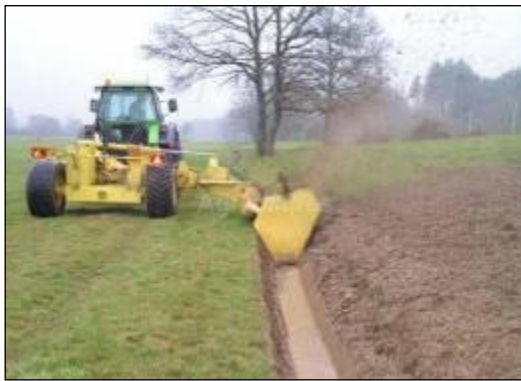
Figure 1 : Exemples de curage et reprofilage de fossé
