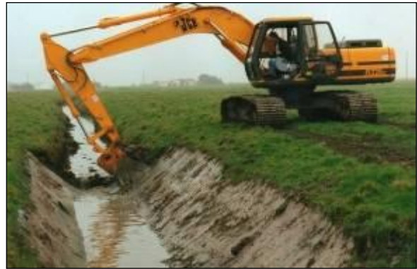
Figure 1 : Exemples de curage et reprofilage de fossé
