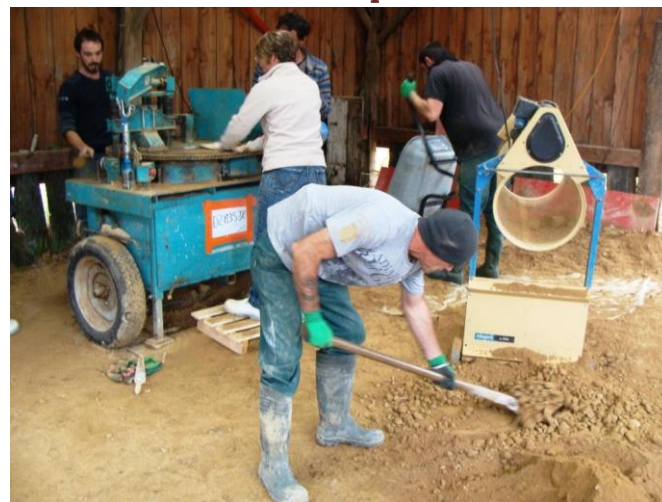
Salariés en insertion et bénévoles ont travaillé ensemble pour la fabrication des briques de terre qui serviront à construire des cloisons dans le groupe scolaire.
