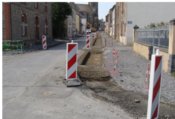
Les travaux de la rue du Soleil levant vont se poursuivre pendant encore quelques semaines
