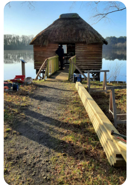
Travaux à la maison du bénin
